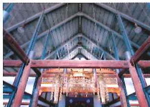
願王寺本堂内部
